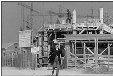
Scuola Collodi-2 in costruzione
